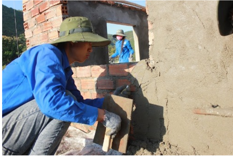
Xây nhà đặt máy phát điện
