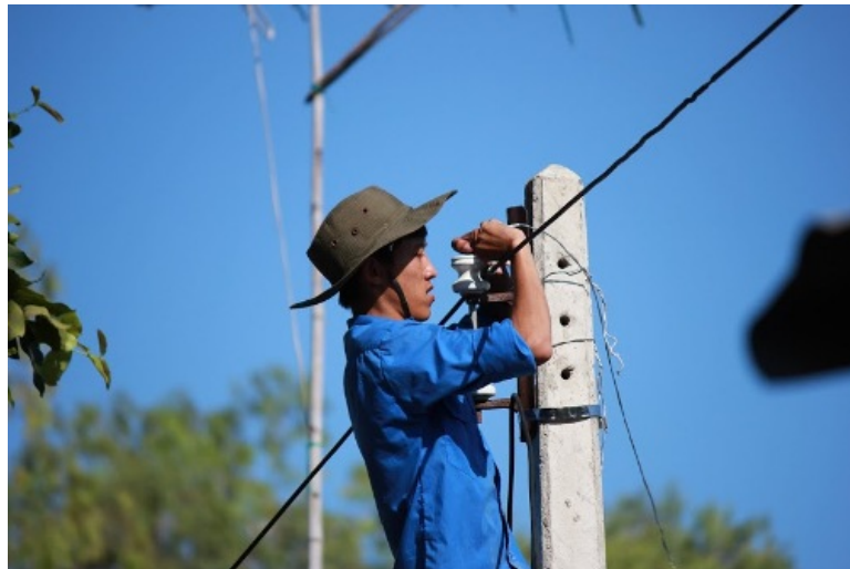
Lắp đặt đường điện cho bà con
