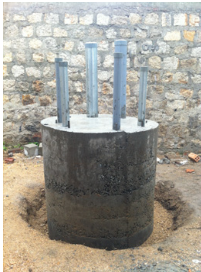
Cọc khoan nhồi sau khi hoàn thành
